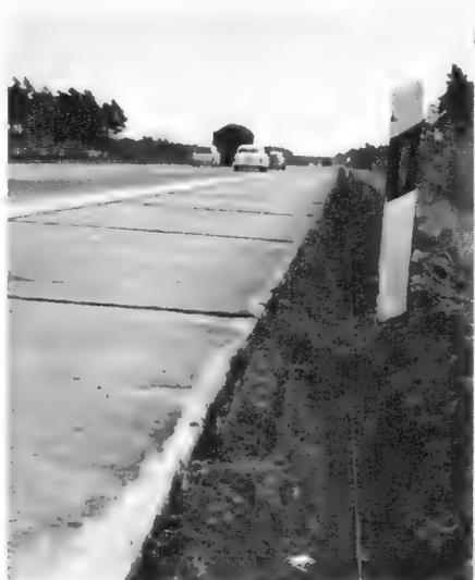
Bild 5. Verlegung der Induktionsschleife neben der Autobahn bei Berkhof, etwa 30 cm tief
